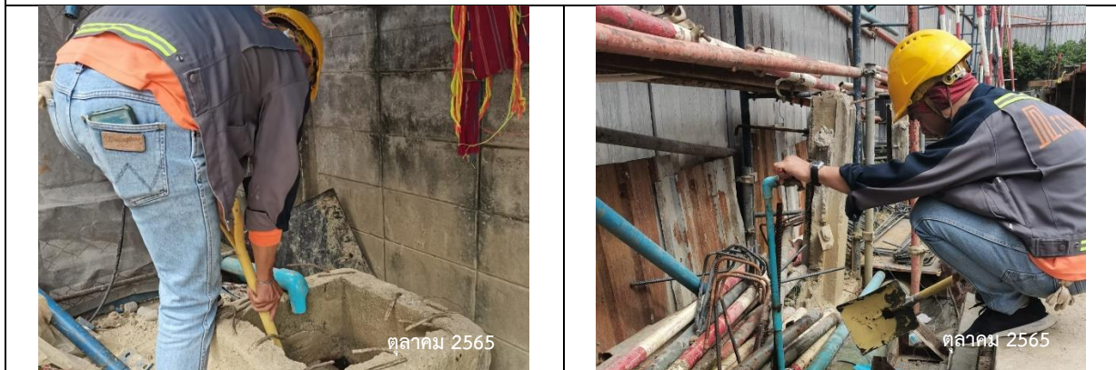
รูปที่ 2-40 การขุดลอกตะกอนดินบ่อพักน้ำ
